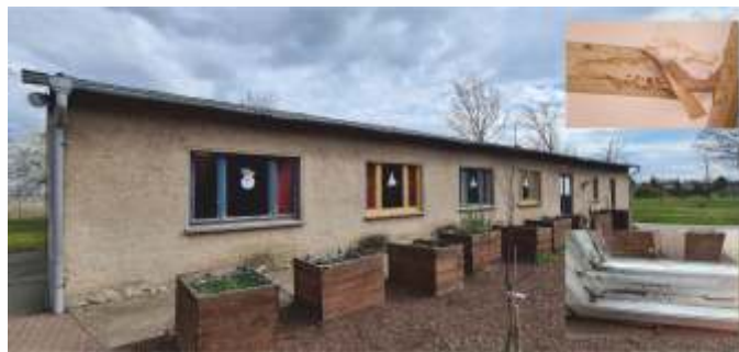
Alter Speiseraum Grundschule An der Muehle Sachsendorf
